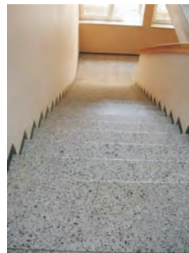
Schlecht zu erkennende Stufen, kein Handlauf - ein Risiko für ältere Menschen!
